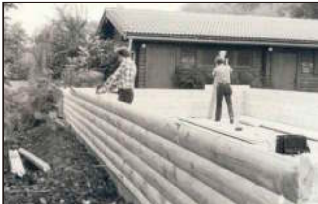
Eerst werden de buitenmuren gestapeld.
