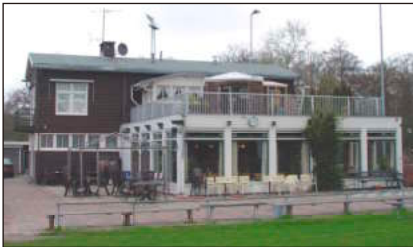
Het huidige ABN AMRO clubhuis. Het gedeelte rechtsvoor is later aangebouwd.
